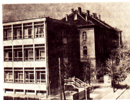
Az iskola épülete
